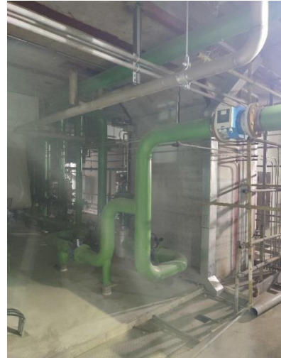
Slika 11 a) i 11 b): Merenje protoka i temperature rashladne vode za hlađenje vodonika
