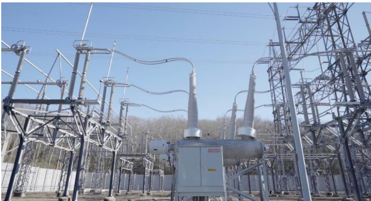
Slika 1. Prekidač 420 kV sa mešavinom gasova CO 2 , O 2 i C4-FN u postrojenju (SAD) 1 .
