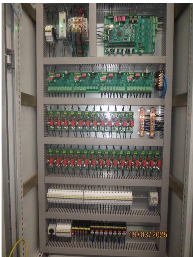
Слика 5: Изглед уграђене опреме у орману Слика 6: Модули тиристора са заштитним и упаљачким електричним колима
