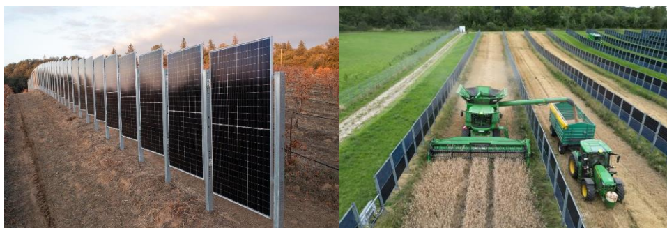
Slika 1: Kombinovanje poljoprivredne proizvodnje i solarne elektrane
