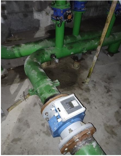
Slika 11 a) i 11 b): Merenje protoka i temperature rashladne vode za hlađenje vodonika
