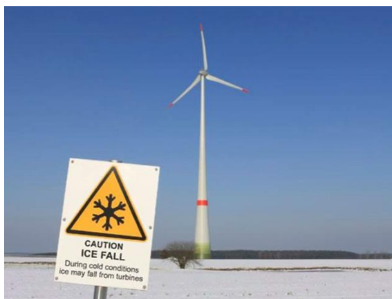
Слика 5.1: Знаци опасности у близини ветротурбина у регијама у којима се може задржавати лед на лопатицама
