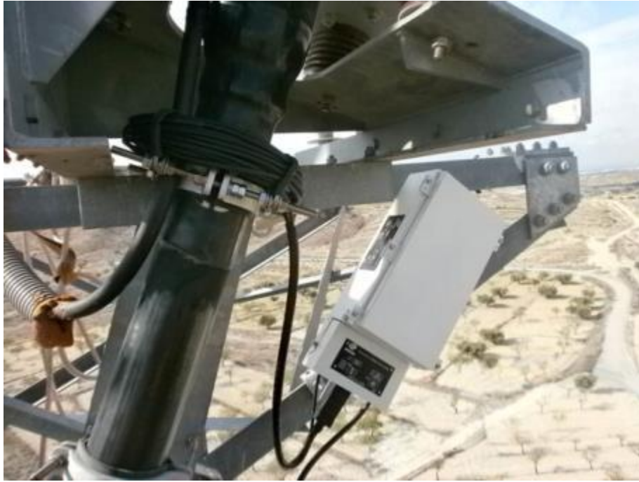
Slika 8: Pasivni optički strujni i prateća oprema na početku kablovske deonice
