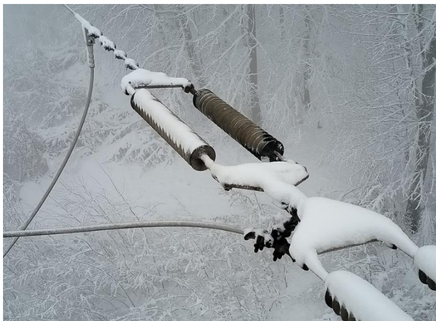
Slika 10: Mjesto kvara na DV 110 kV Banja Luka 1- He Bočac
