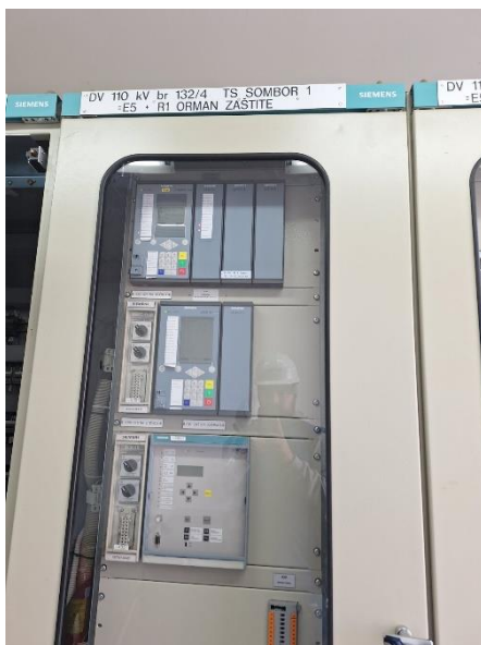
Слика 5.4.1: Слика уграђених заштитних уређаја у +R орман заштите ТС 400/110 kV Сомбор.
