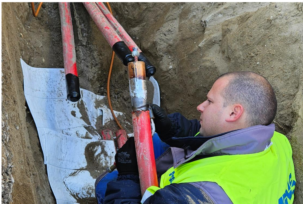
Slika 5: Montaža kablovske kape za injektiranje azota
