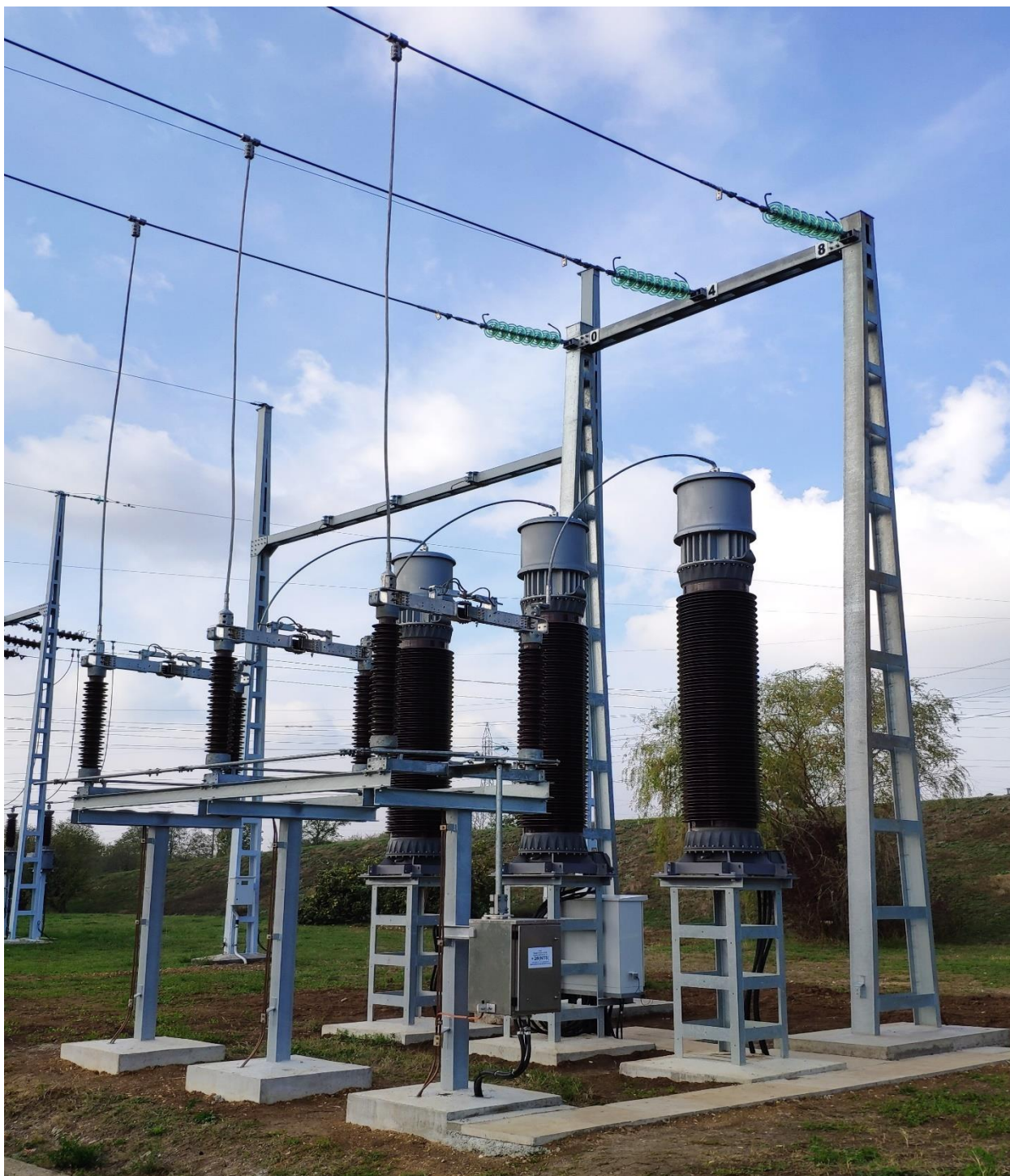
Slika 2. Ugrađeni NTS u polju E03
