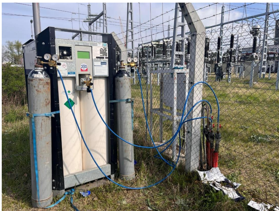
Slika 6: Injektiranje azota na deonici TETO – Beograd 45
