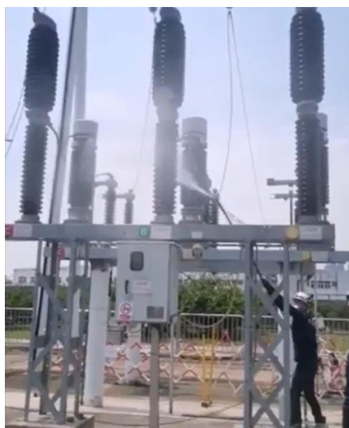
Slika 5: Čišćenje izolatora prekidača 110 kV
